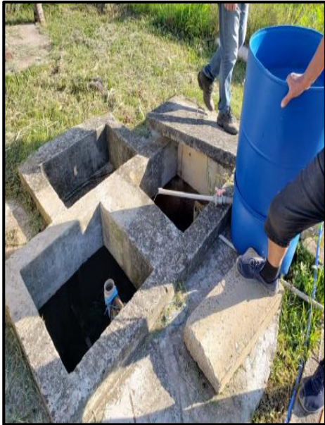
Figura 110. Dosagem de Enzilimp na entrada do efluente.
