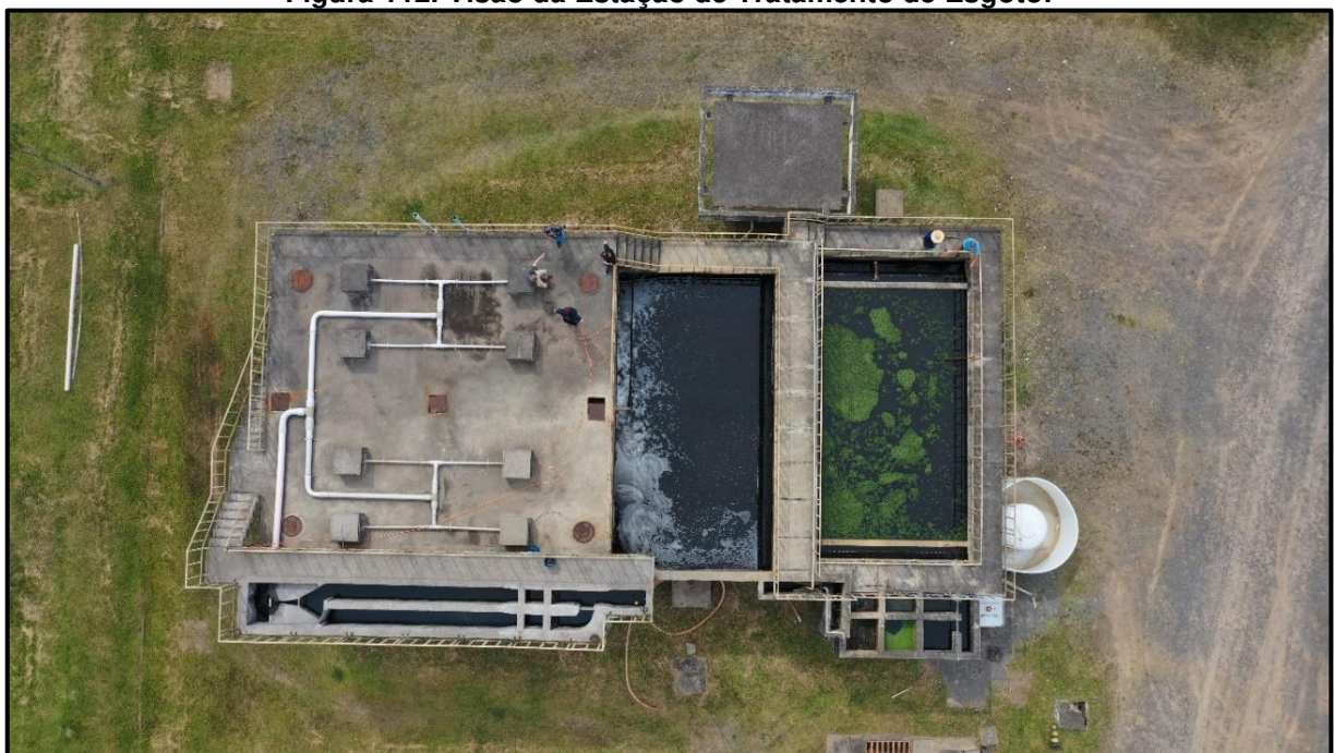
Figura 112. Visão da Estação de Tratamento de Esgoto.
