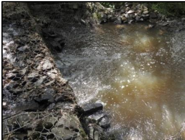
Figura 83. Barragem para captação da água Passo do Portão.
