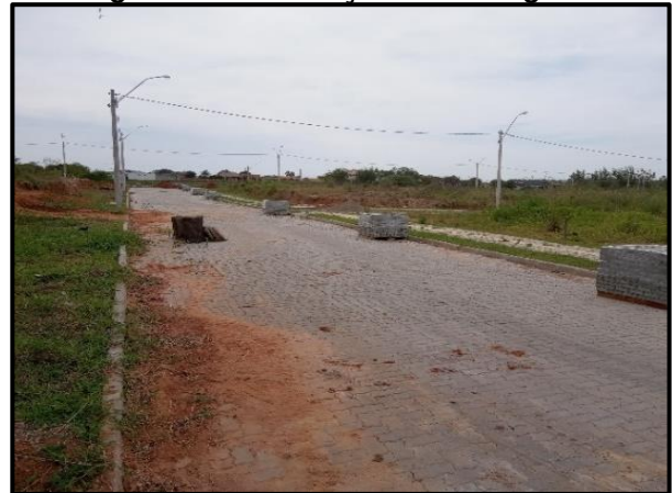
Figura 21. Construção de drenagem.
