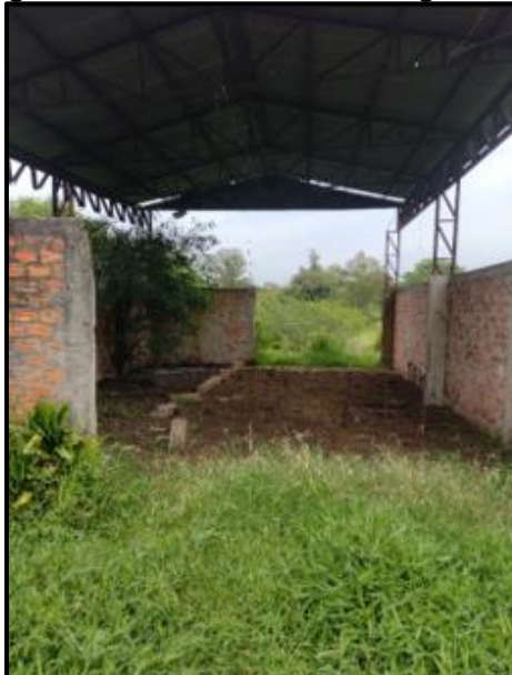
Figura 54. Área desativada/antigo lixão.
