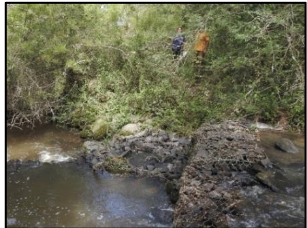
Figura 84. Barragem do Arroio Passo do Portão.
