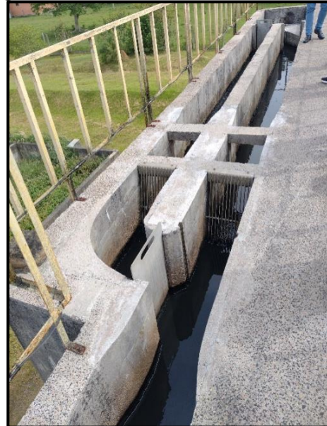
Figura 111. Gradeamento e desarenador.
