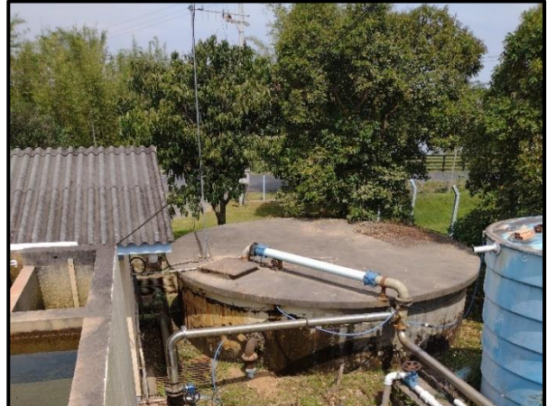
Figura 75. Reservatório da ETA.
