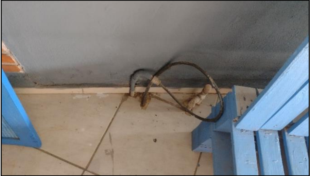
Figura 96. Poço da SAC.
