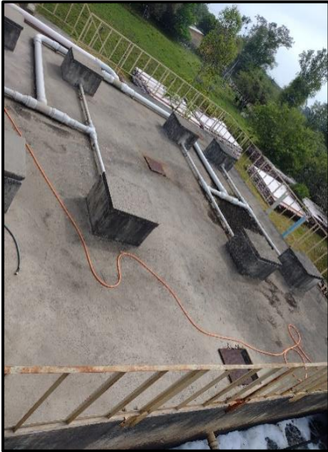
Figura 113. Reator UASB da ETE-Glorinha.
