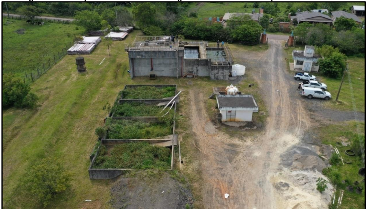
Figura 107. Estação de Tratamento de Esgoto Sanitário do município de Glorinha/RS.
