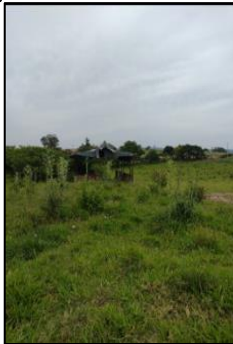
Figura 57. Aterro controlado e monitorado.
