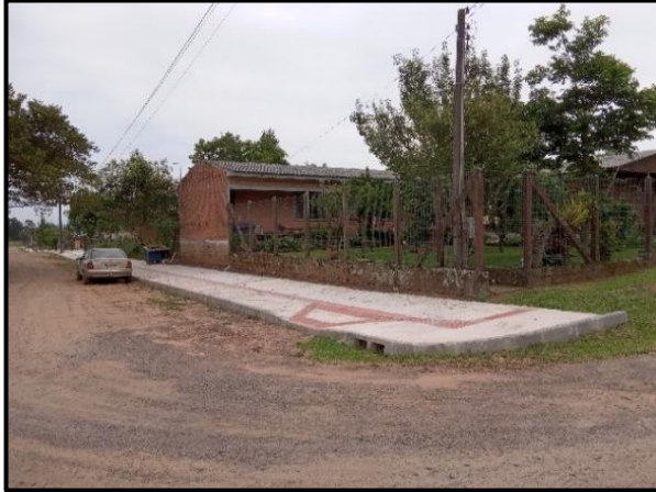
Figura 22. Boca de lobo.
