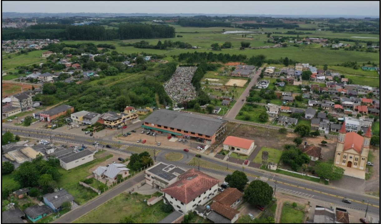
Figura 12. Pavimentação no centro de Glorinha/RS.
