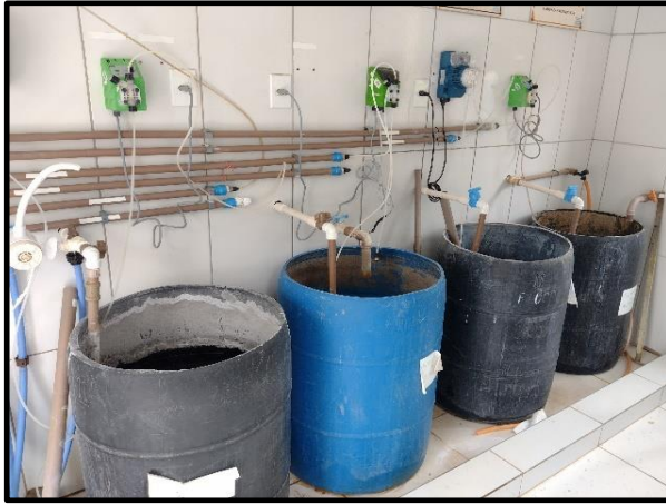
Figura 70. Local de desinfecção (fosfato de alumínio, flúor, cloro)
