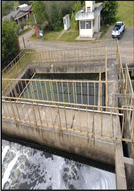
Figura 115. Floculador da ETE-Glorinha.
