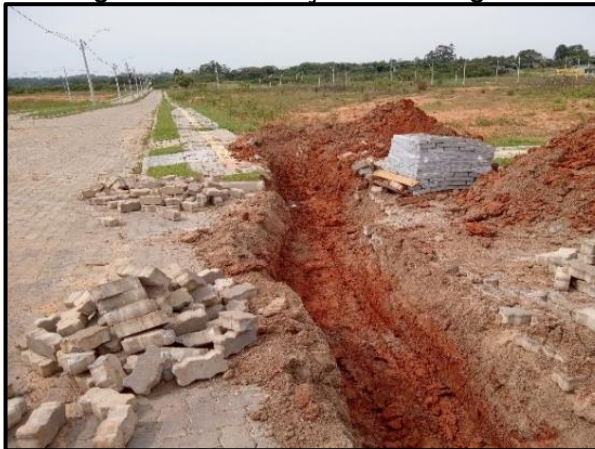
Figura 20. Construção de drenagem.
