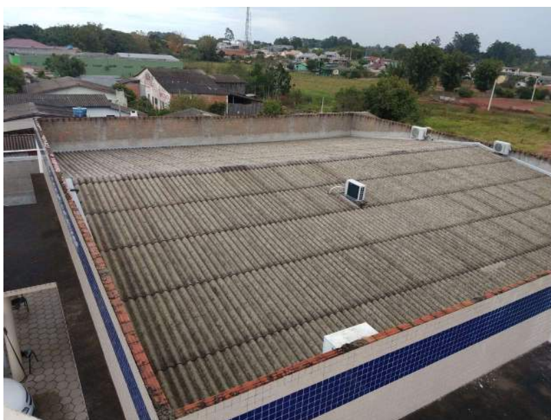
Figura 2: USF MARIA DA GLÓRIA- cobertura
