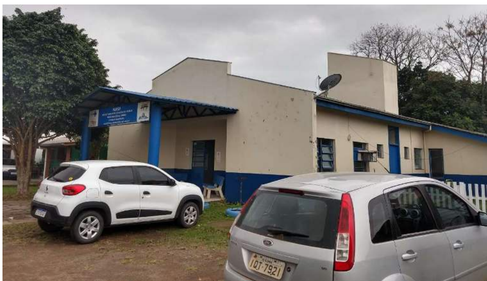
Figura 5 – Fachada principal- Clinica de Reabilitação
