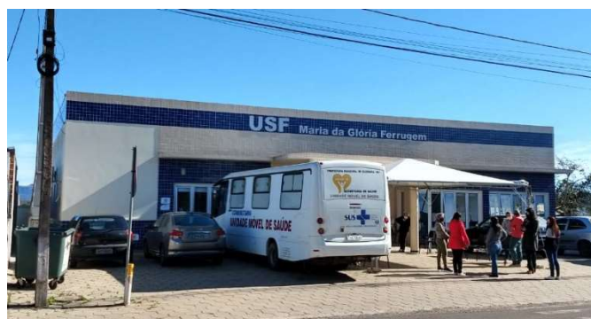
a) Vista fachada Sudeste
