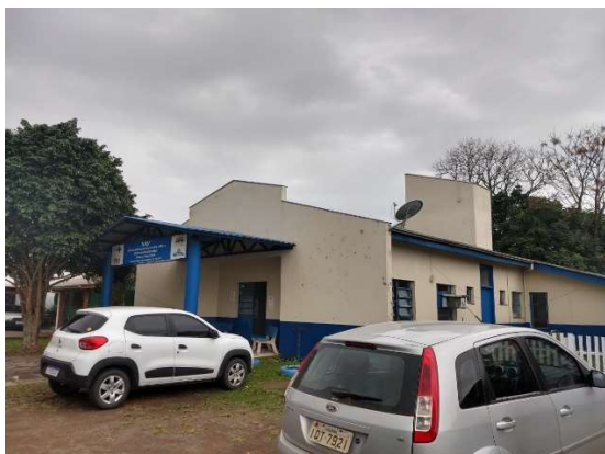
a) Vista fachada Sudoeste
