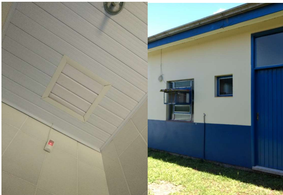
Figura 6 – Interno – Clínica de Reabilitação
