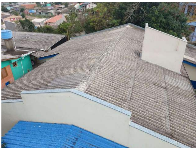
Figura 4: CLINICA DE REABILITAÇÃO – cobertura
