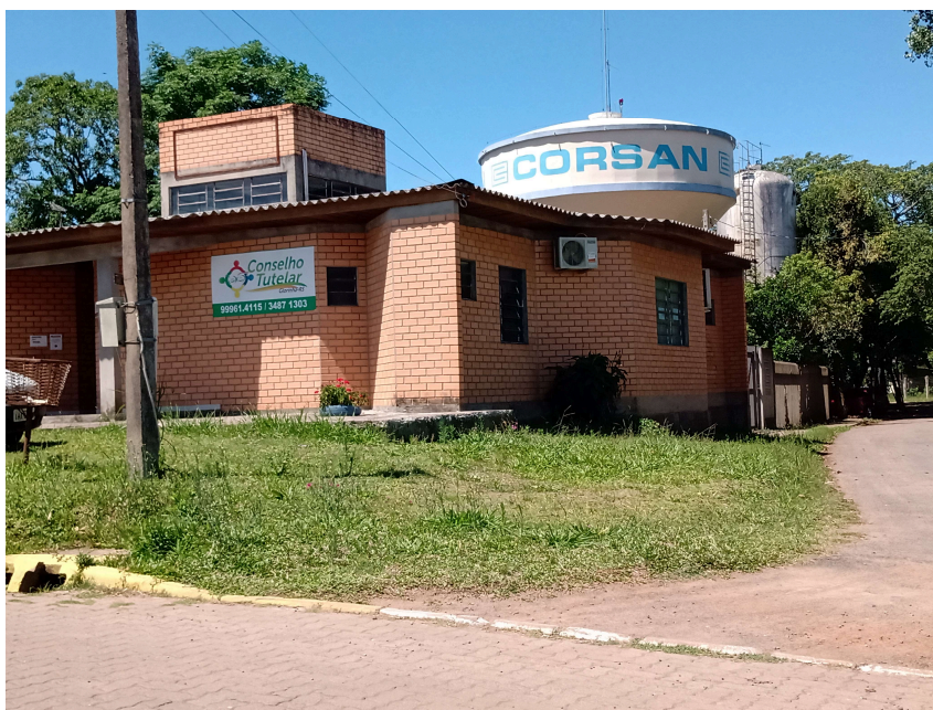
Foto 3: Prédio a ser reformado, vista da esquina
