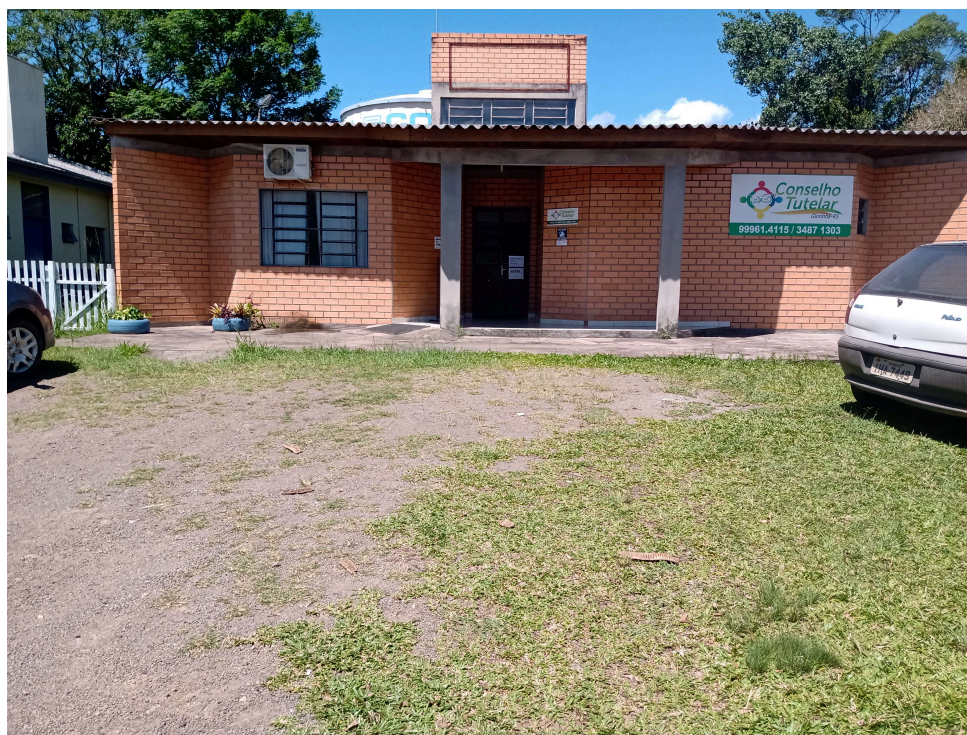
Foto 2: Prédio a ser reformado
