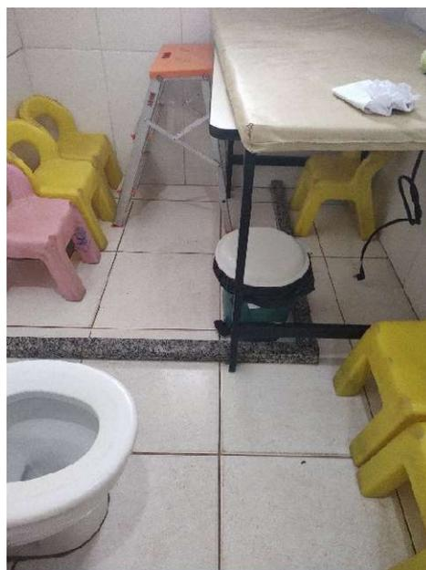
No fraldário / sanitário "11", deverá ser retirada a delimitação do box existente no local e ser feita revisão hidráulica pois o vaso sanitário apresenta entupimento frequente e um dos mictórios não está funcionando.
