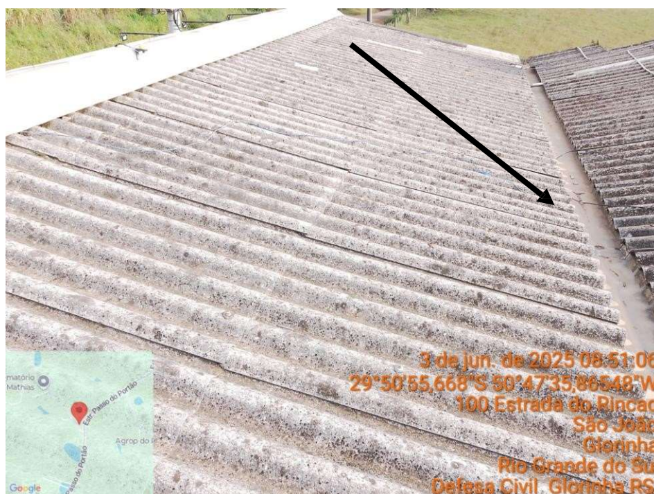
Imagem 5. Foto da calha existente – local onde será instalada nova calha, de maior dimensão que a atual.
