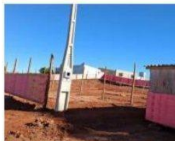
a) Quadro de medição b) disjuntor geral (63A)
