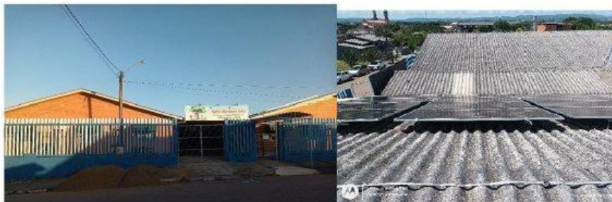
Figura 1 – Fachada principal- Emei Isdra Abrahamm Isdra (antes da colocação gradil pré-moldado)
