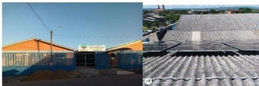
Figura 2 – Fachada principal- Emei Isdra Abrahamm Isdra (antes da colocação gradil pré-moldado)
